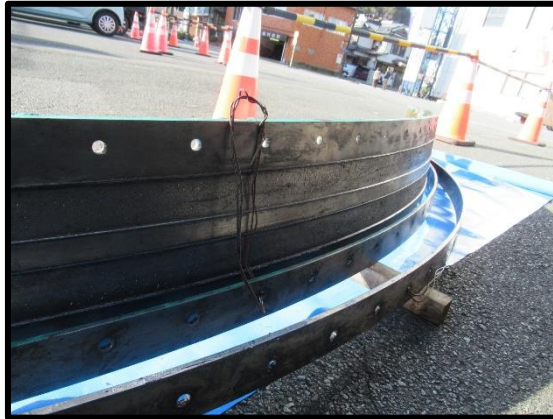
(取り外した旧メインプレート)
