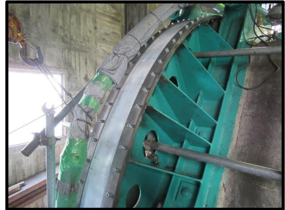
(新メインプレート取り付け)
