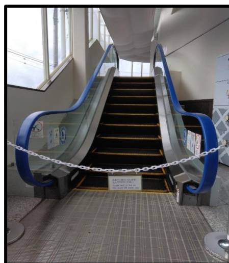
(エスカレーター乗車口)
