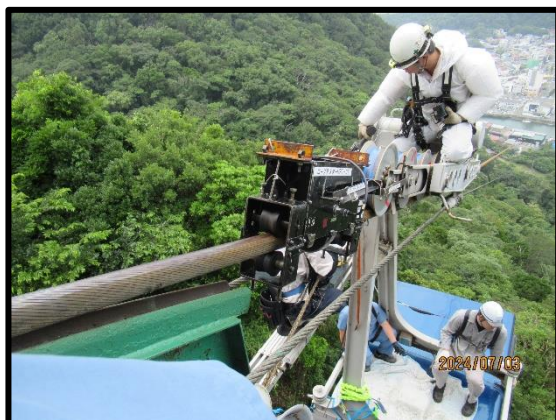
(検査機器の取付け)
